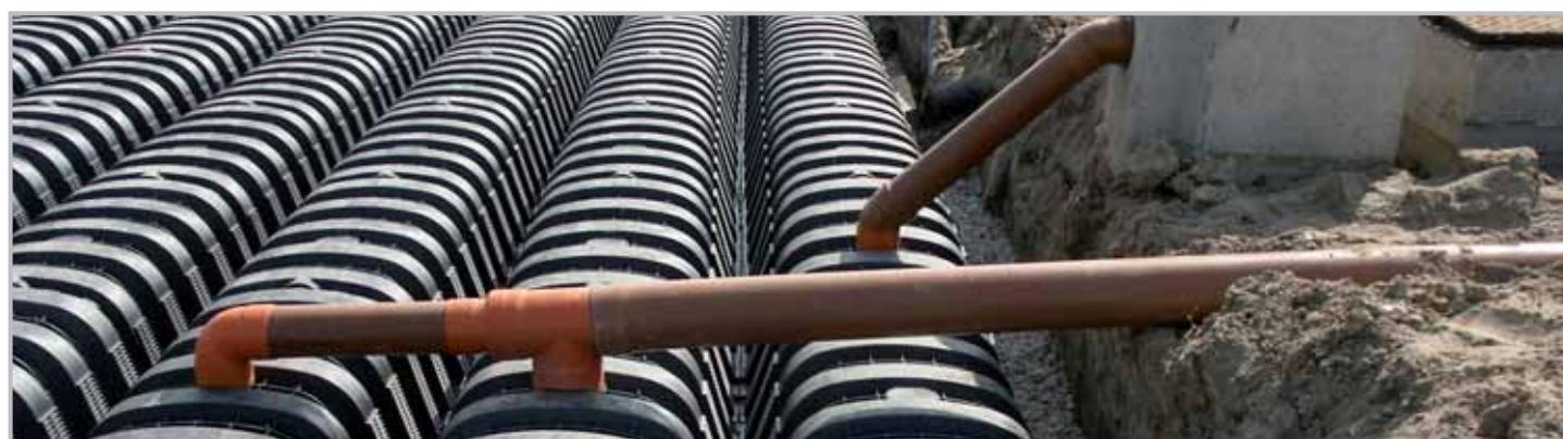
рисунок 9) Пример подсоединения труб в верхней части системы DRENING®.
