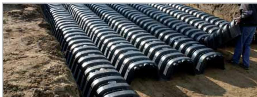
Рисунок 3) Укладка вручную.
