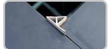
Chamfer fillet
