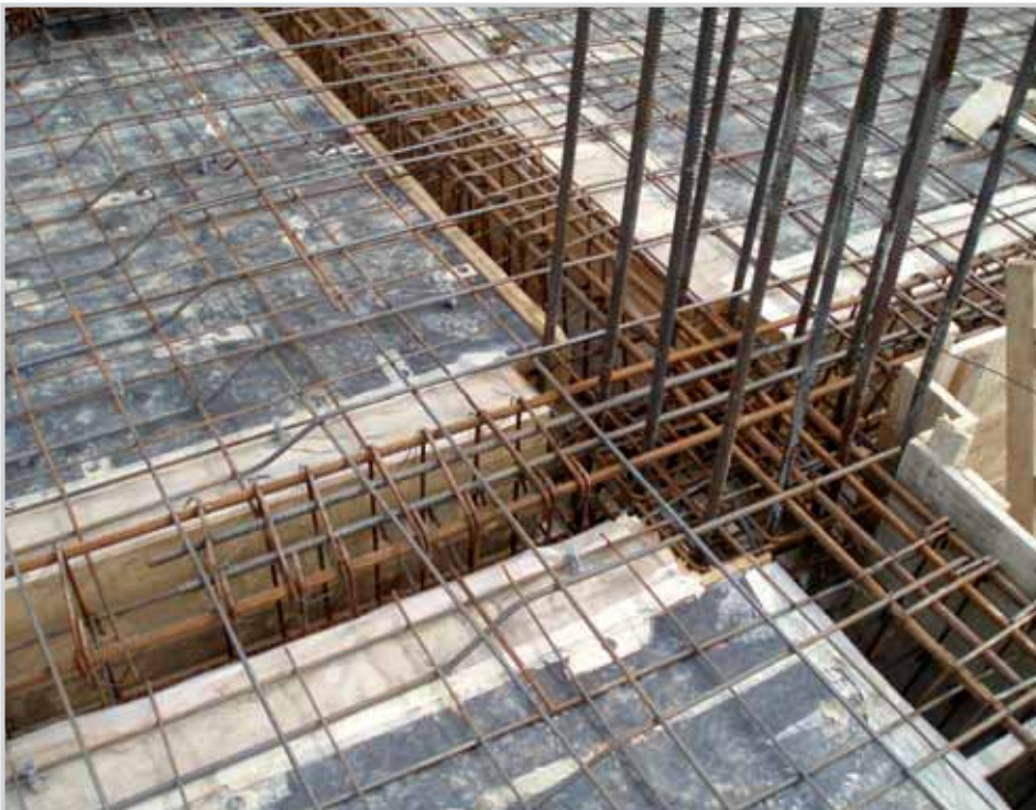
Пример одновременной заливки перекрытия и балок
