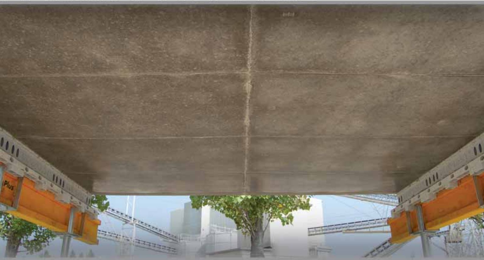
СИСТЕМА ПЛАСТИКОВОЙ ОПАЛУБКИ ДЛЯ ПЕРЕКРЫТИЙ С УСКОРЕННОЙ РАСПАЛУБКой
