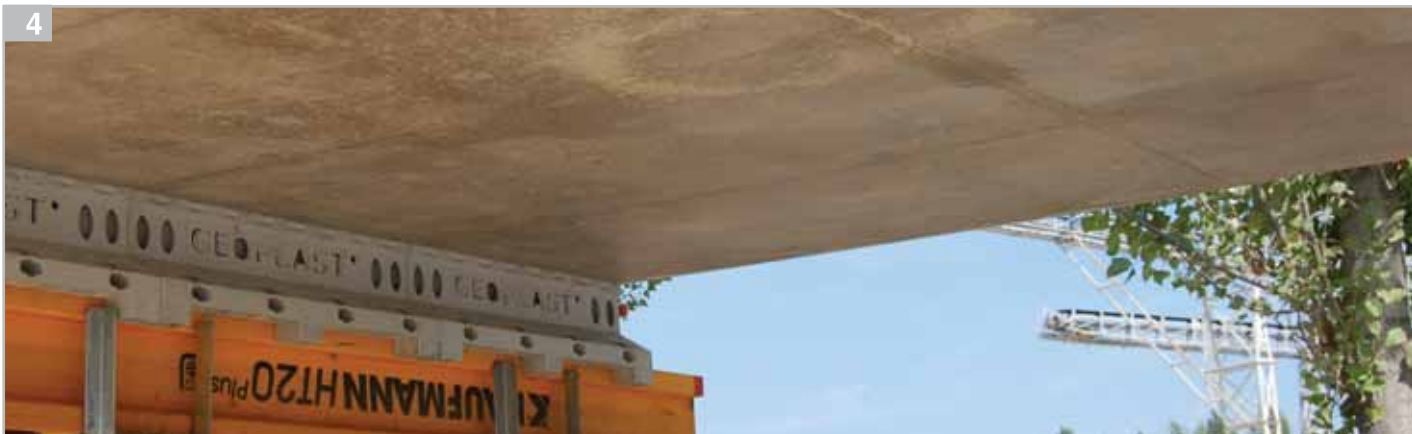
4 Конечный вид до полного высыхания бетонированной поверхности
