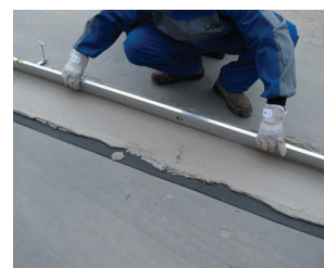
4. Kezdősor alatti habarcságy kialakítása nivelláló készlettel
