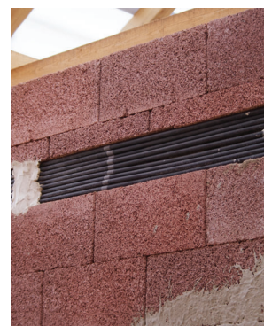
15. Mart hornyba süllyesztett vezeték
